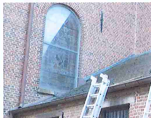
Opgaand muurwerk met solins in lood (rechts) en koper (links).
