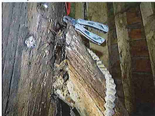
Inrotting van aansluitende onderdelen.
