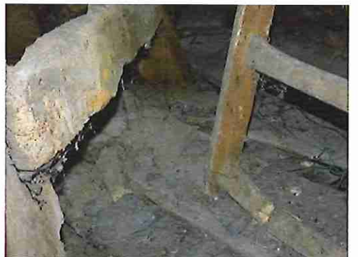
Bovenste platform torendak, vermolmde ladder.
