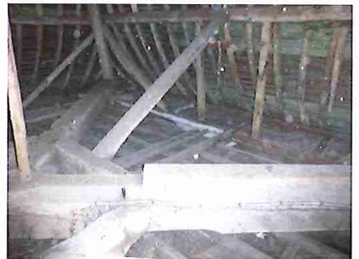
Ontbrekende bevoering op onderste sterplatform.
