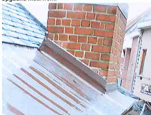
Opgaand muurwerk met solin in koper.
