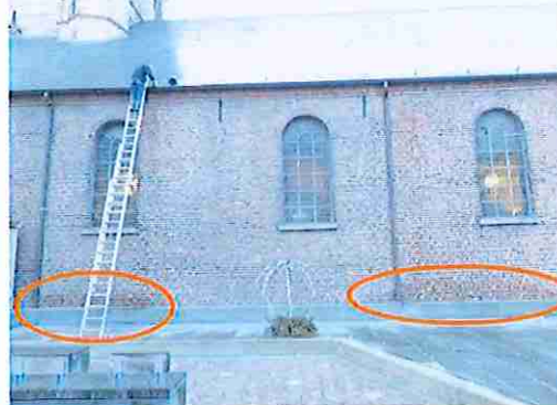
Zuidzijde; natte muren door overlopende goten.
