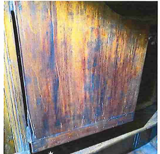
oude insectenaantasting- een scheur ter hoogte van de onderste scharnier- opvallende afwerking wat kleur betreft
