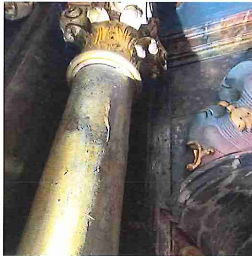
opstuwing van het verpakket op de zuilen
