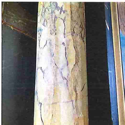
was-hars fixatie met zijdepapier
