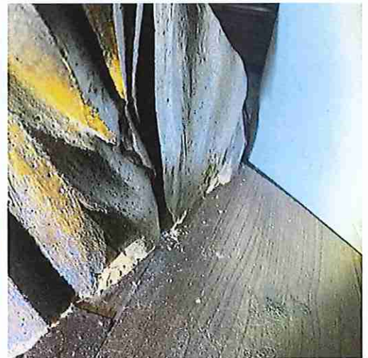
verzwakking van hout door insectenaantasting onderaan de basis
