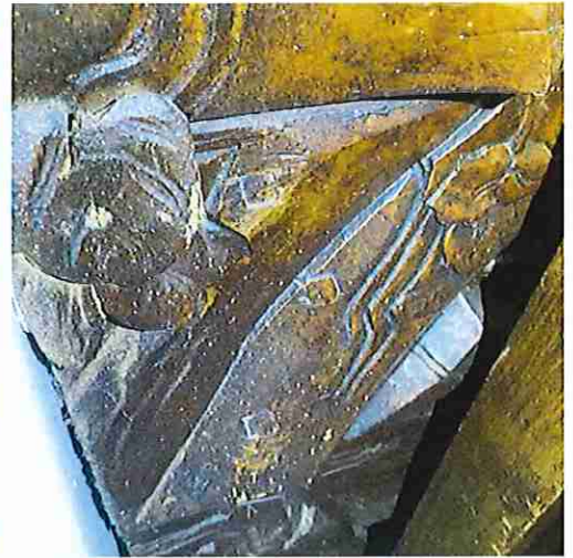
loszittend onderdeelje houtsnijwerk (links onder de kuip)
