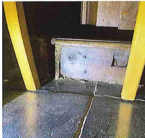
de plint bevat sporen van oude insectenaantasting
