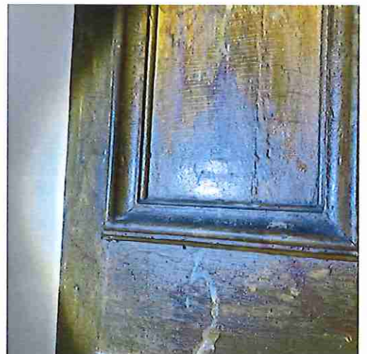
verfopstuwing op de vlakke delen met marmerimitatie
