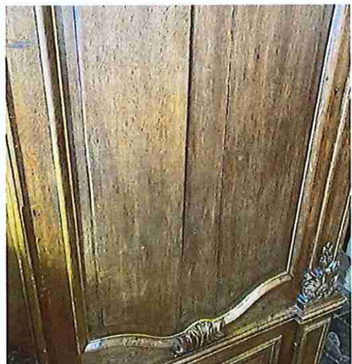
opbollende panelen als gevolg van vochtbelasting (niet recent)
