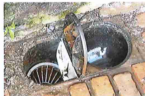
idem, na verwijderen van de afvoerpijp
