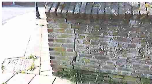
zettingsscheur
