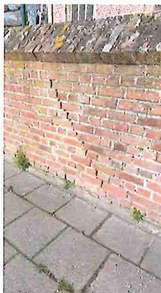
zettingsscheur
