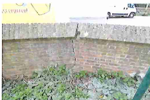
zettingsscheur
