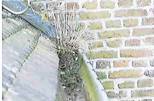
verstopt tapgat waardoor het water niet meer in de afvoer geraakt.
