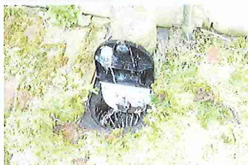
correct afvalputje met geopend deksel
