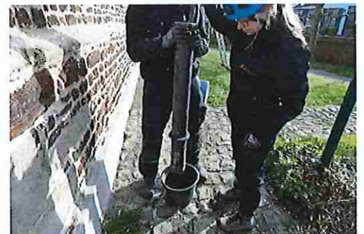
demonteren en uitkoteren van stampijpen
