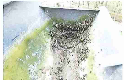
idem, na wegscheppen bovenste vuil; de onderliggende tapbuis was over een lengte van 40 cm verstopt met vuil
