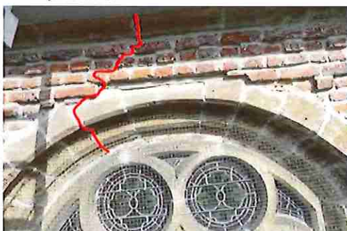
bovenzijde scheur
