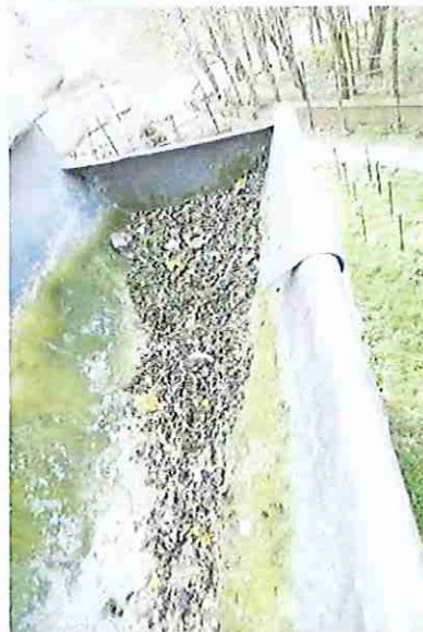
verstopt tapgat waardoor het water niet meer in de afvoer geraakt
