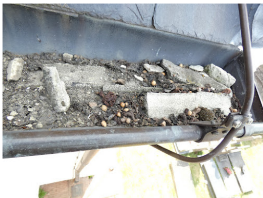
door afval en vuil verstopte afvoer
