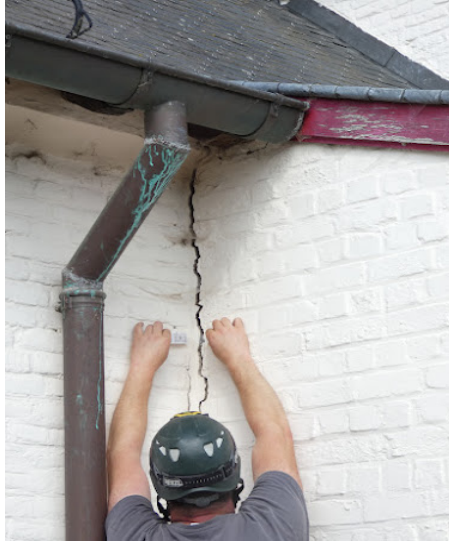
plaatsen van hoekscheurmeter
