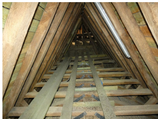
losliggende loopplanken op transept
