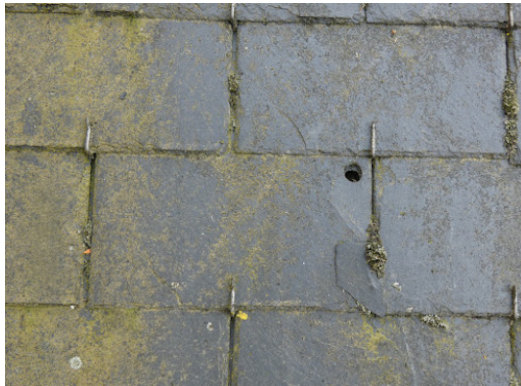
perforatie van dubbele lei
