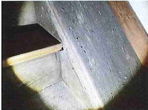
aangetast boom doksaaltrap: boormeel
