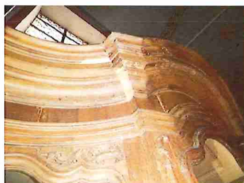
vernieuwde stukjes houtwerk/ongelijkmatige kleur
