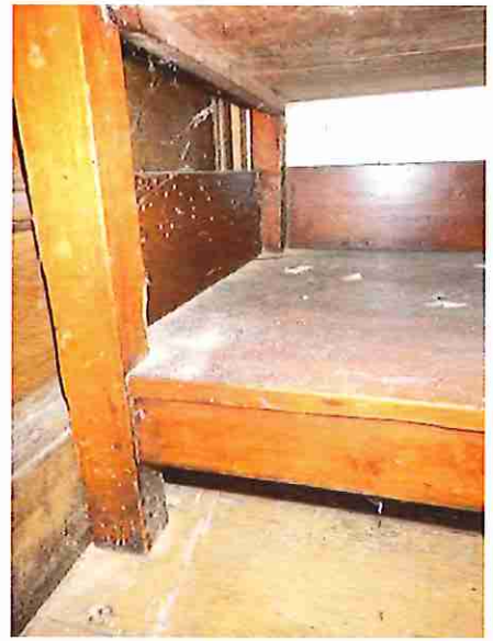
uitvliegopeningen en hoopjes boormeel
