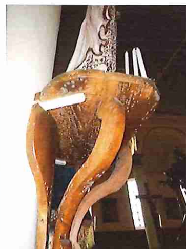
Onze-Lieve-Vrouw Onbevlekt Ontvangen oppervlakteschimmel op de console
