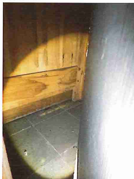
ter hoogte van de plint: hoopjes boormeel
