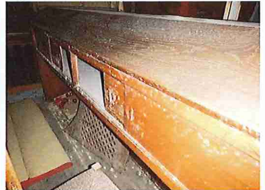
oppervlakteschimmel/aantasting door kleine klopper
