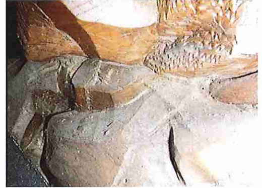
uitvliegopeningen van grote klopkever/boormeel
