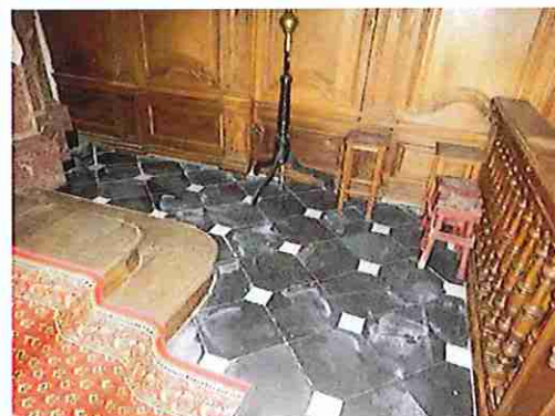
overzicht oudere vloeren koorsluiting en zijaltaren
