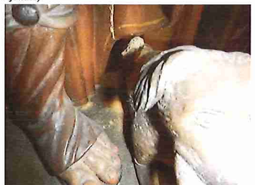
St-Rochus (zuidelijke aanzet koor) boormeel (insecten of plaatsing anti-diefstalbeveiliging)
