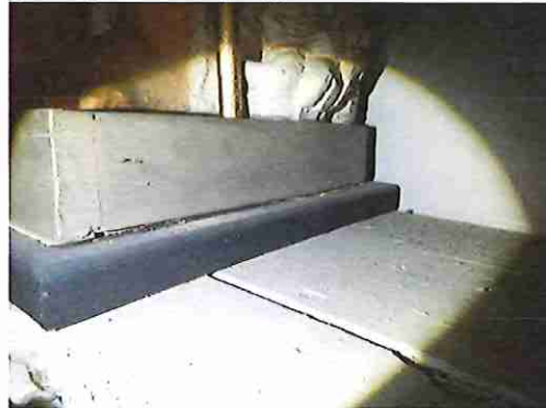
boormeel sokkel St-Jan de Doper (nis zuidelijk zijaltaar)
