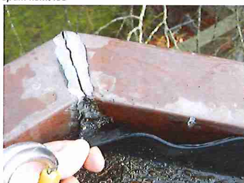
epdm komt los/bovenaan nog gescheurde naad
