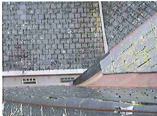
afwerking kilgoot met stuk EPDM
