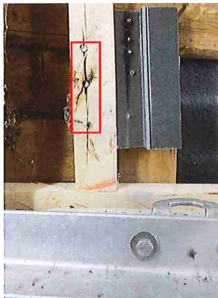
de bevestigingsbouten werden afgezaagd
