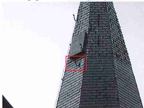
de bevestigingsbouten werden afgezaagd
