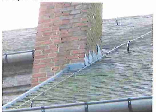
schoorsteen-aansluiting
