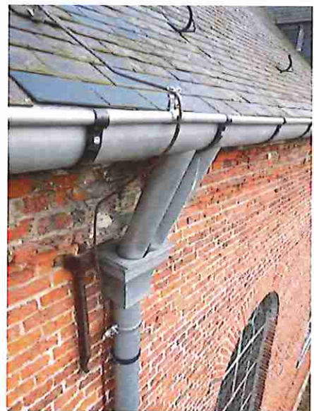
afvoer-aansluiting met vergaarbak
