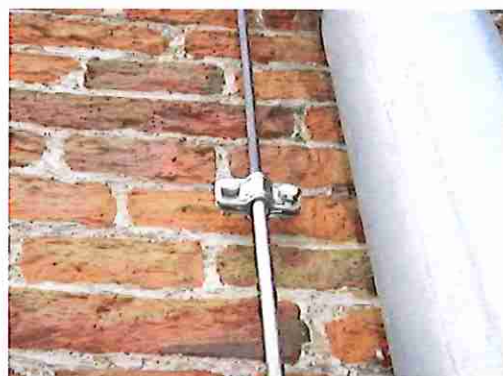
bliksemafleider-bovendeel koper en onderste stuk in roestvrij staal
