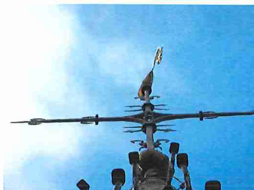
torenkruis-wat roestdoorslag
