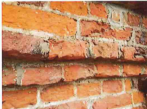
baksteen-beschadigde bakhuid
