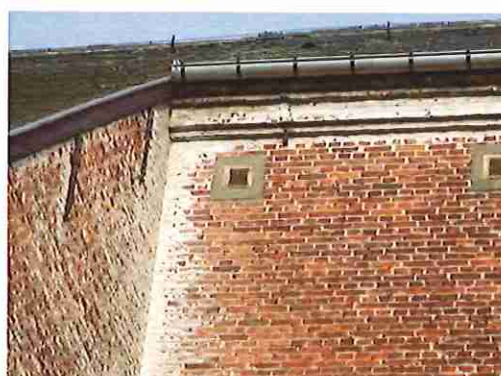
koor-afgesleten afwerklaag
