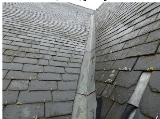
Algemeen beeld van de kilgoot langs de buitenkant.
