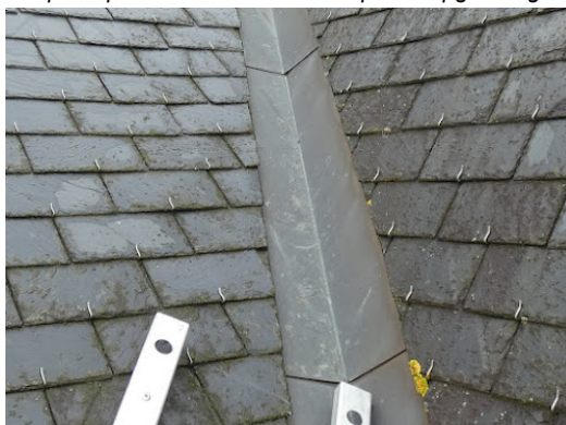
Bovenzijde van de kilgoot. Let op de gelijke zijdelingse overlapping tussen de leien van de zijbeuk (links) en de leien van het transept (rechts).
