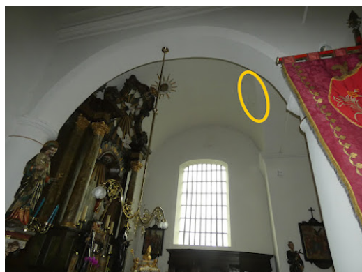
Lokalisering van de gevolgschade door waterinsijpeling aan het stucplafond van het zuidelijke transept, voor het Sint-Lambertusaltaar.
