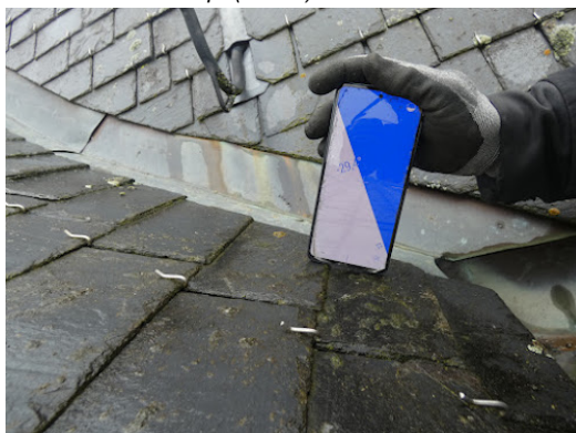
Verskil in hellingsgraad tussen het dak van de zijbeuk (30°) en dat van het transept (60°).
