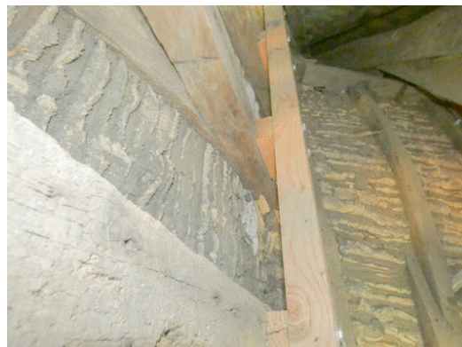
Toestand van het stucgewelf op de zolder: op het moment van de inspectie opgedroogd.
