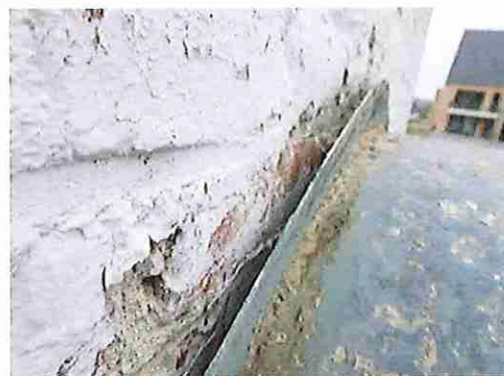
Openstaande aansluiting bovenzijde.
