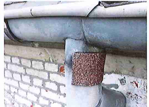
Herstellingen met roofing.
