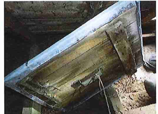
Onderste torenluik : ontbreken van een rand.
