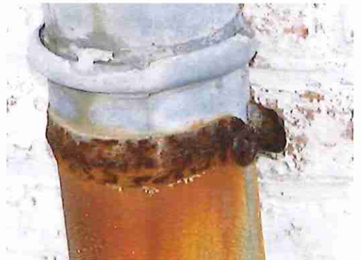
Verroeste afvoerbeugels.
