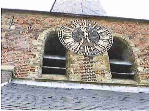
Opgaand muurwerk met loden slabben.
