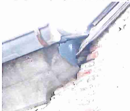
Overgang zuidelijke zijbeuk naar zuidtransept.
