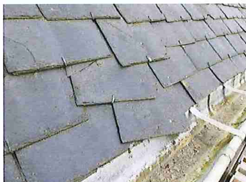
Gebroken en afschuivende leien.
