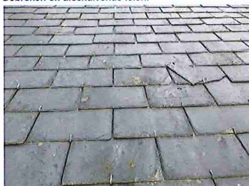
Gebroken en afschuivende leien.
