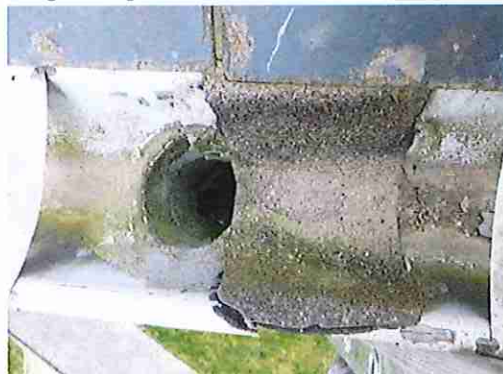
Herstelling met roofing.
