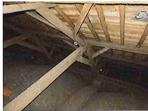
Kapconstructie boven hoofd- en zijbeuken.
