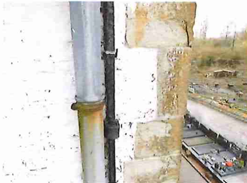
Gecorrodeerde afvoerpijpen.
