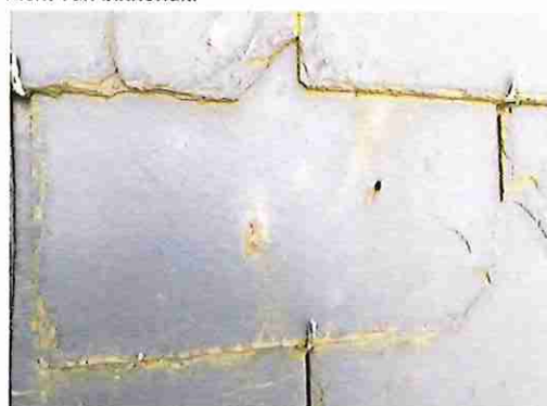
Pyrietverontreiniging in de leisteen.
